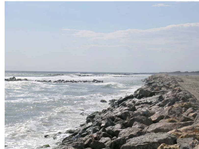
Affaïssement et déracinement des épîs de la plage du Grand Radeau (PNRC, 25.04.06)
